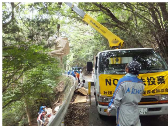
④ ユニック車による廃棄物の引上げ
